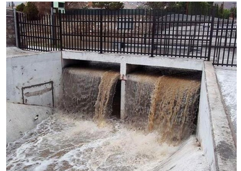
El Paso storm water project, El Paso, TX
